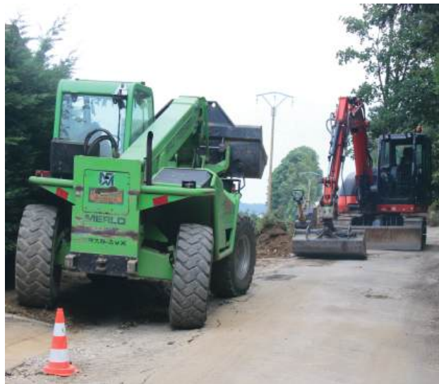
Les engins sont nécessaires pour creuser la voirie jusqu'au réseau.
